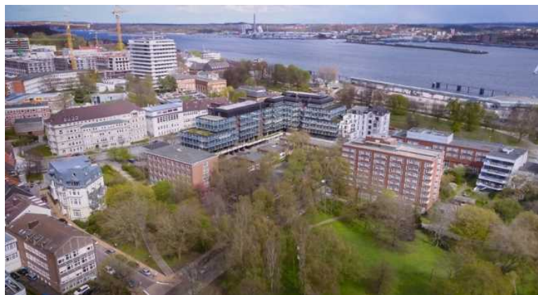
Luftbildaufnahme mit Umgebung, Förde, Ratsdienergarten mit Kleinem Kiel und USKH in unmittelbarer Nähe, Bild: 3komma3.
